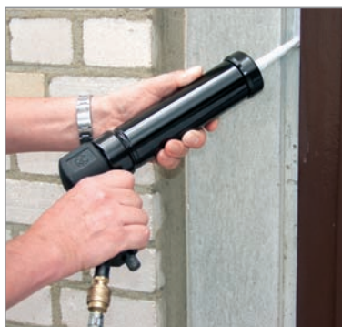
Inyectado: relleno de ranuras limpio y profesional
